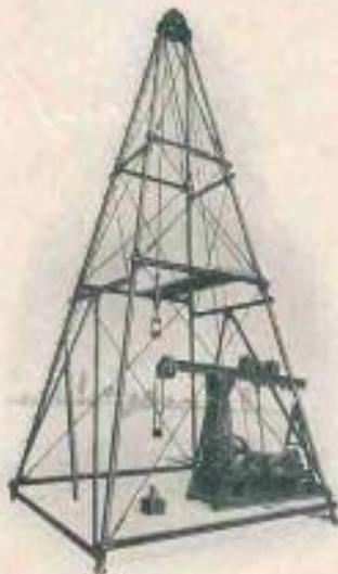
Fig. 2. Treuil de Forage à chute libre disposé sous une tour en tubes d'acier.
