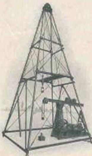
Fig. 2. Treuil de Forage à châte libre disposé sous une tour en tubes d'acier.
