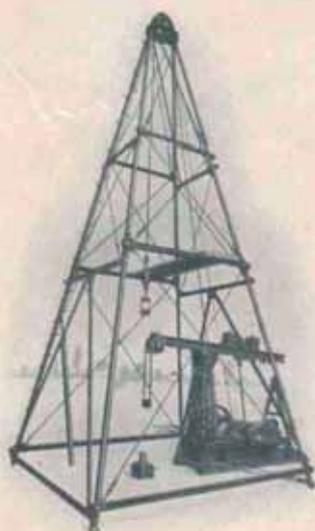
Fig. 2. Treuil de Forage à chute libre disposé sous une tour en tubes d'acier.
