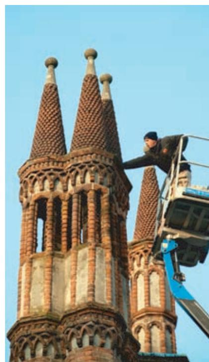
Mercoledì 23 febbraio, alla presenza dell'arch. Camilla Burrelli funzionario della Soprintendenza per i Beni Ambientali e Architettonici delle provincie di Parma e Piacenza, è stato effettuato il controllo della tesatura dei quarantotto trefoli della torre. Tale operazione doveva esser effettuata nel 2001 per verificare l'equa distribuzione del peso della torre sulle colonne portanti. L'esito è stato confortante, anche se nei prossimi mesi sarà necessario un ulteriore intervento di manutenzione.
